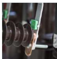
Sensor TH110 montado en terminación de cable
